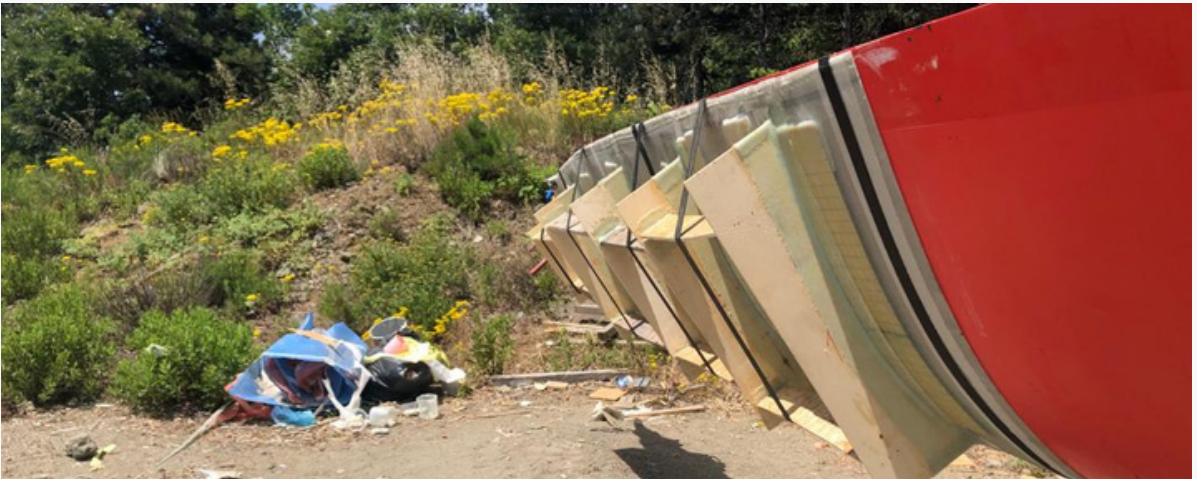
Kalıp Hazırlığı ve Kanat Tamiratu
